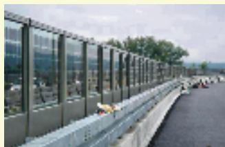
Barriera stradale al rumore con integrazione del fotovoltaico all'interno dei vetri temperati
