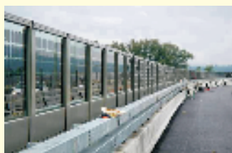
Barriera stradale al rumore con integrazione del fotovoltaico all'interno dei vetri temperati
