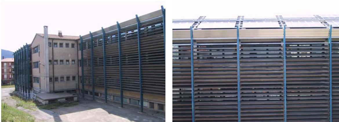
Facciata integrata per (sistema di riscaldamento a loop convettivo, brise soleil e produzione fotovoltaico)
