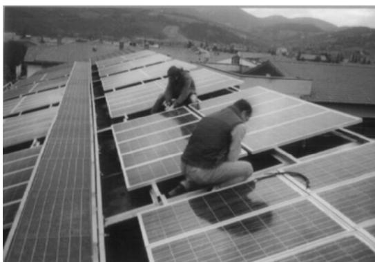
Figura:3 Montaggio del sistema fotovoltaico
